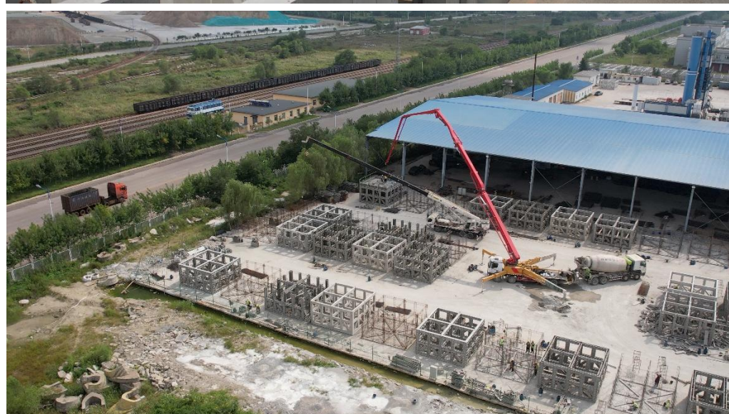
优秀奖：项目施工现场风貌-亚泰预制沈阳公司 王帅
